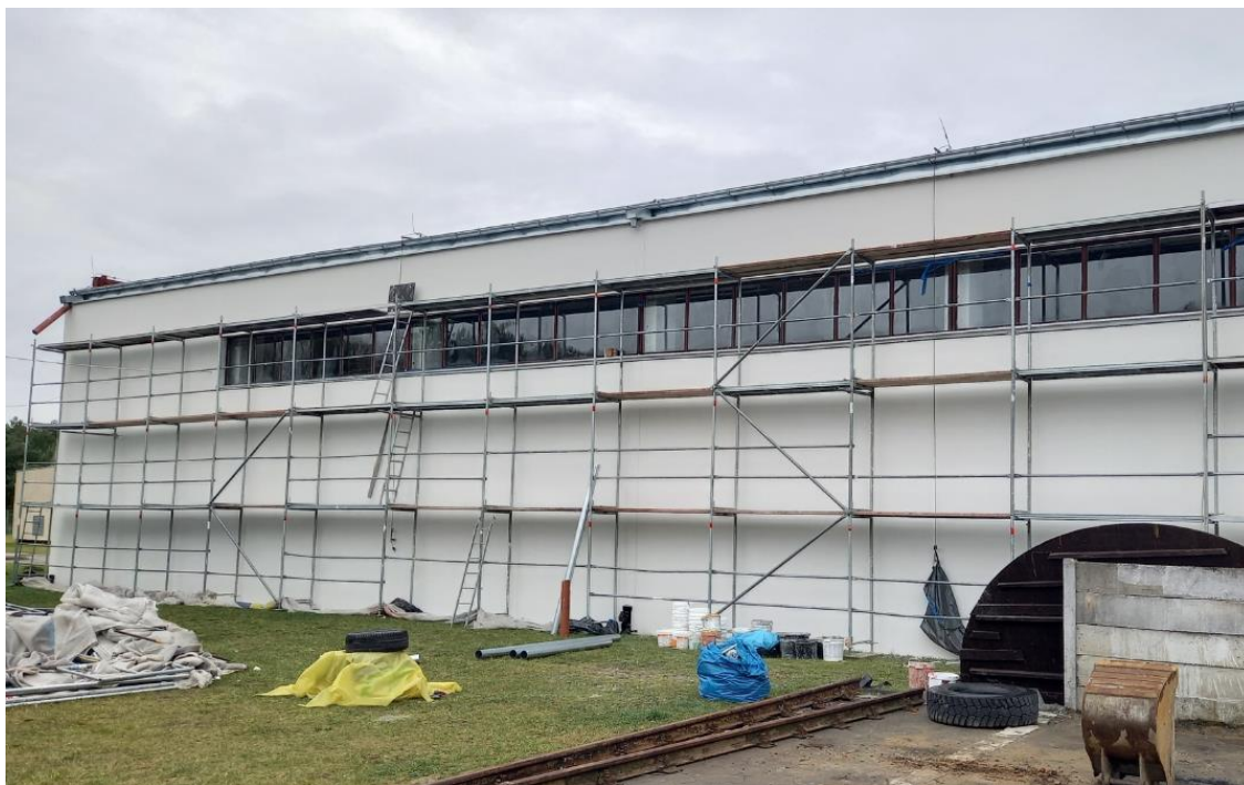
Foto: MZWIK sp. z o.o. w Golubiu-Dobrzyniu (Termomodernizacja budynku hali pomp i filtrów SUW „Białkowo”)
