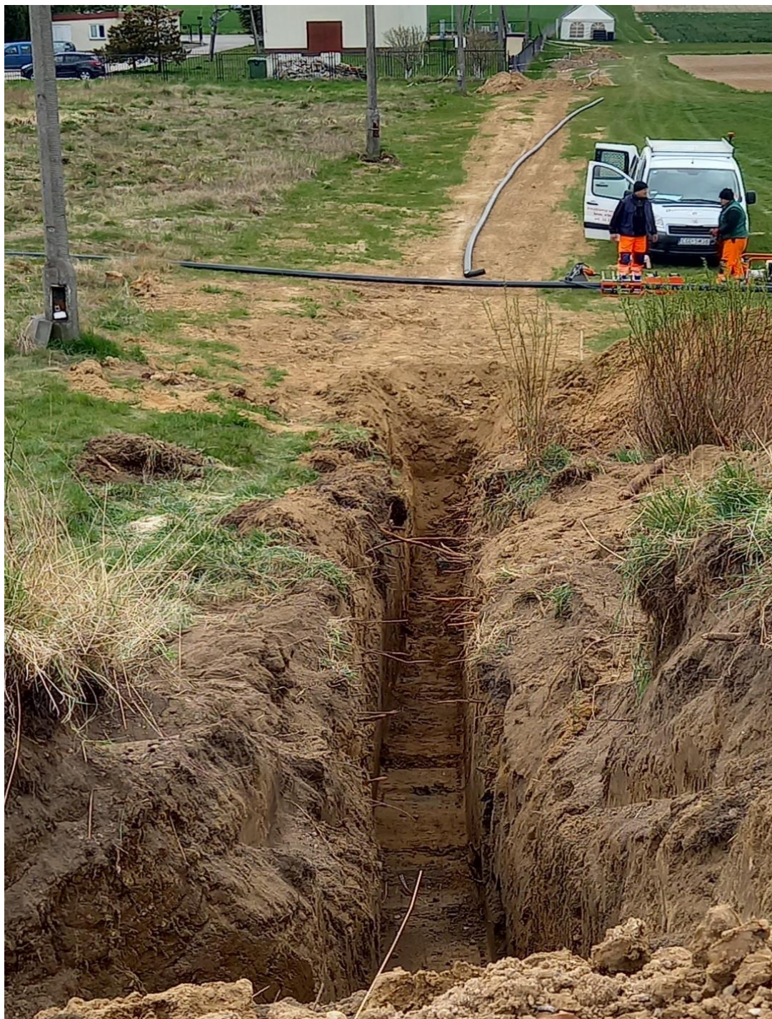
Foto: MZWIK sp. z o.o. w Golubiu-Dobrzyniu (Budowa spinki wodociągowej Dworcowa-PTTK)
